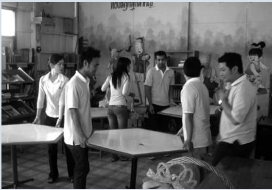
+ พนักงานทิสโก้ร่วมมือร่วมใจซ่อมและปรับปรุงห้องสมุด
